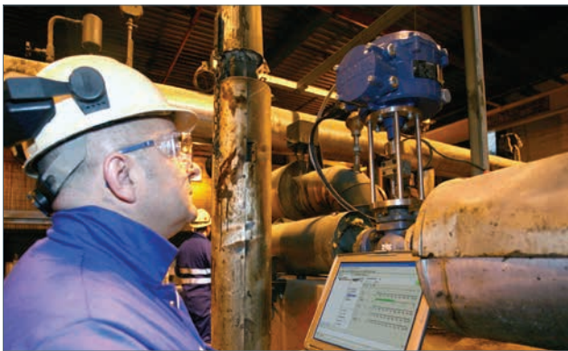
Figure 1. La motorisation CVA peut être configurée grâce à un appareil équipé de la technologie sans fil Bluetooth tel qu'un PDA ou un PC, ou via un communicateur HART.
