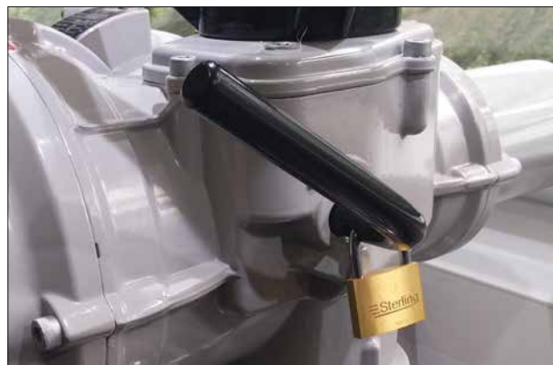
Fig 7.1. Verrouillage du levier manuel-auto de l'IQ3
